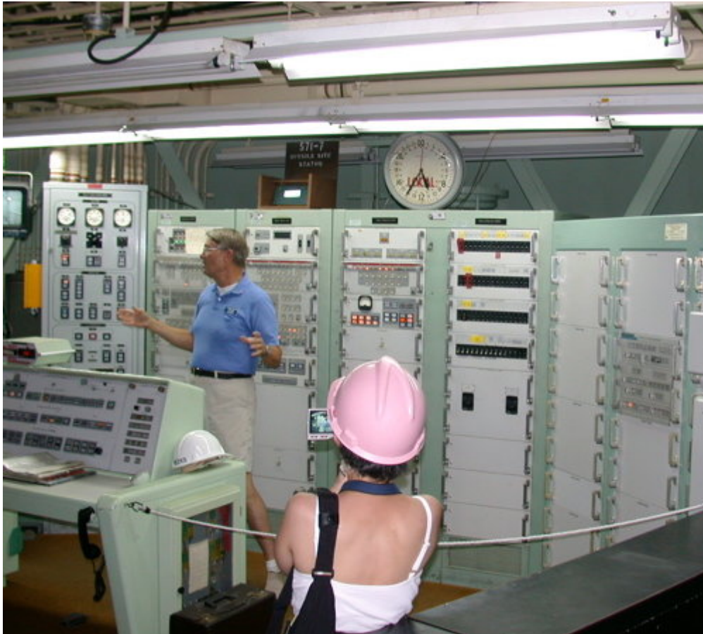
Originalfoto aus dem Titan II Missile Silo der US Air Force in South Arizona. (Bild: Guido Frank)
